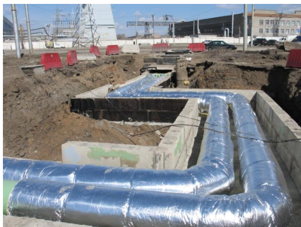
Рис.1 Участок трубопровода в канале
